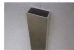
躯体に、アルミ縦胴縁を専用ビスで取付けます。
