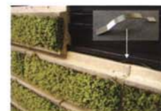
割付に従ってアルミ下地レールに陶板を取付け、ステンレスクリップで固定します。
